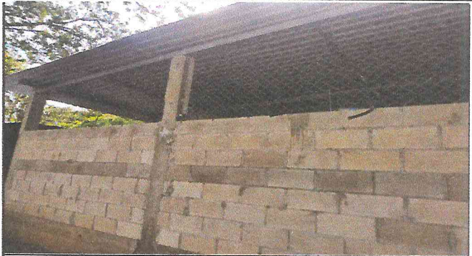
Foto 2: colocación de malla, estructura metálica y lámina
