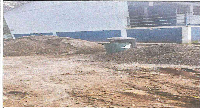
Foto 1: Acarreo y acomodación de material para la escuela
